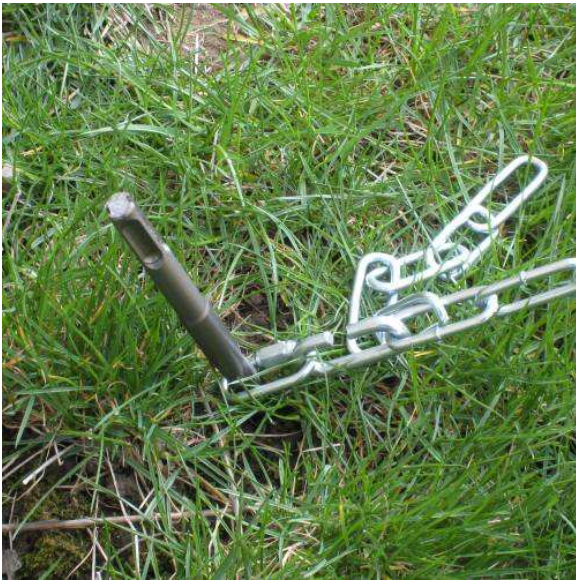
Figura 58: ancoraggio a terra delle catene di tiraggio.
