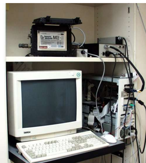
Figura 3: “Computer di acquisizione”
