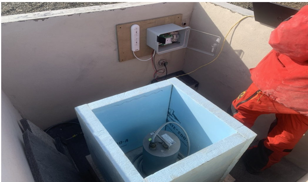
Installazione e isolamento termico del sensore a banda larga nella Base Petrel
