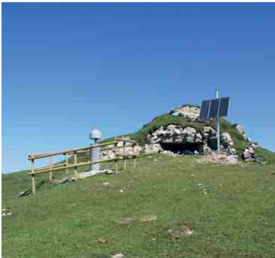
Figura 6: Stazione Master ACOM, sul Monte Acomizza vicino a Tarvisio
