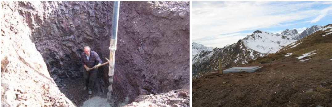
Figura 1.10: Scavo alla profondità di 5 m per la realizzazione della stazione a banda larga di Zoufplan (sx) e stazione finita (dx).
