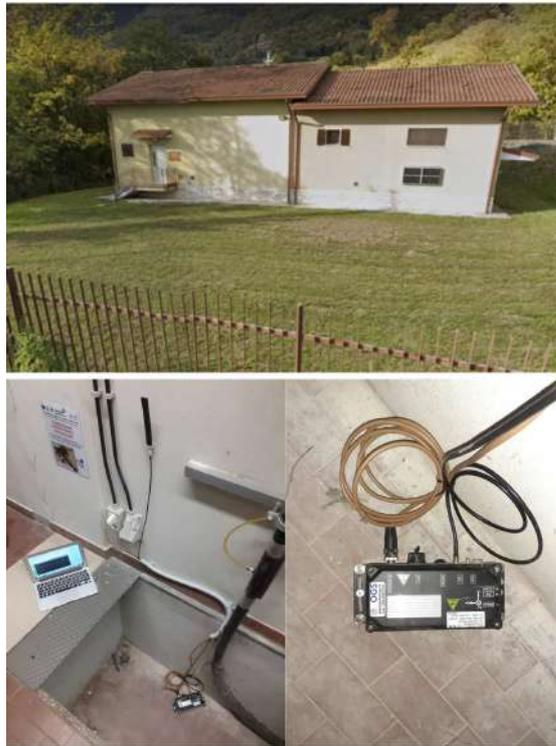
Figura 6.4: Installazione di un accelerometro presso una centrale TIM
