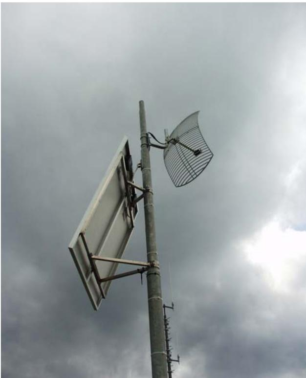
**Fig. 12:** particolare di un palo di sostegno con pannelli fotovoltaici e antenna trasmisiva.
