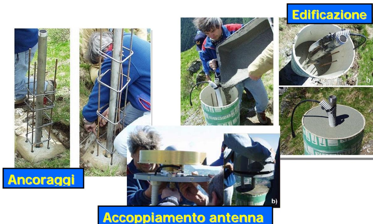
Fig. 7: da sinistra a destra i vari passaggi per la monumentazione su roccia. Nella foto di sinistra in alto un dettaglio sull'accoppiamento del palo in acciaio con lo strato di roccia affiorante. A destra in alto il getto della monumento in cemento (colonna alta 1m e diametro 35cm). Nella foto al centro l'operazione finale di accoppiamento dell'antenna al palo in acciaio e la copertura dell'antenna con una cupola protettiva.
