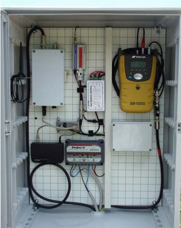
**Fig. 10:** quadro elettrico contenete l'apparato radio, il ricevitore GPS, le interfacce di rete e i sistemi di alimentazione e protezione elettrica.
