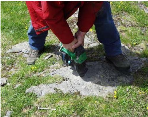
**Fig. 18:** operazione di foratura con trapano tassellatore a batteria.
