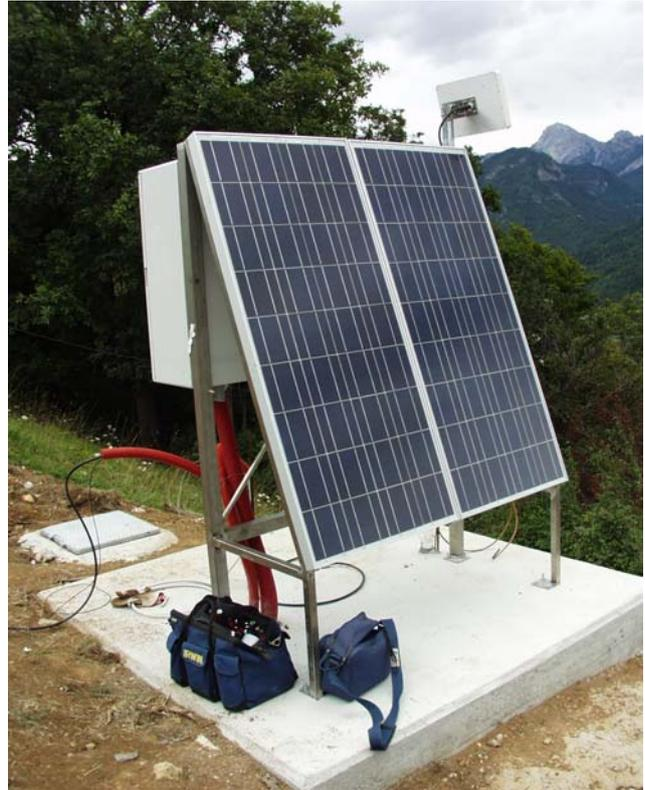
**Fig. 11:** traliccio con pannelli fotovoltaici installati. Sulla sinistra è visibile il pozzetto per le batterie di backup.
