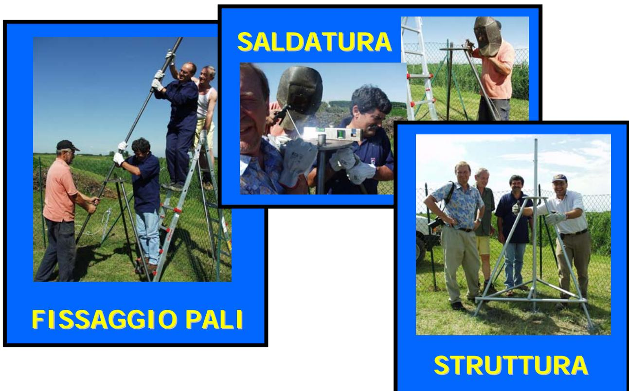
Fig. 8: esecuzione di una monumentazione su terreni sciolti. A sinistra la prima fase di fissaggio delle barre in acciaio, al centro la saldatura sul disco centrale e destra il monumento realizzato.
