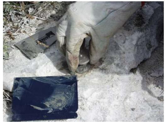
**Fig. 19:** il caposaldo è infilato nel foro e fissato alla roccia con colla bicomponente.
